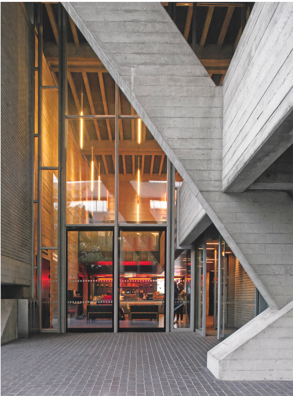
Eine mächtige Stahlbeton-Tragstruktur formt den Raum; die feine Glaswand teilt nur beliebig zwischen aussen und innen.
