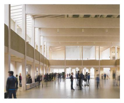
turell ein Stabbauwerk, ein Skelettbau – so der Statiker Konrad Merz. Das Ungewöhnliche daran ist die Dichte und die heute kaum mehr praktizierte Sichtbarkeit der Konstruktion. Frappierende Details ergeben sich so – etwa die geschossweise gesteckte Gabelstütze mit kraftschlüssiger Lastabtragung senkrecht zu ihrer Faser.
