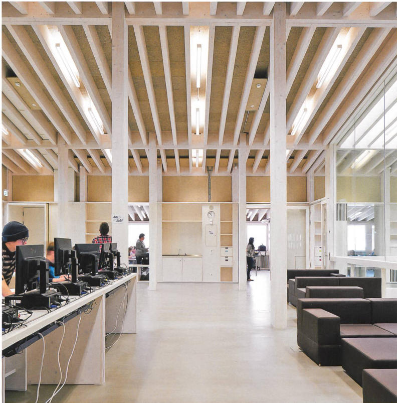
Überall ist Holz präsent, und die Konstruktionsschichten sind ökonomisch genutzt, als Nischen für Installationen oder als Wandschränke.
