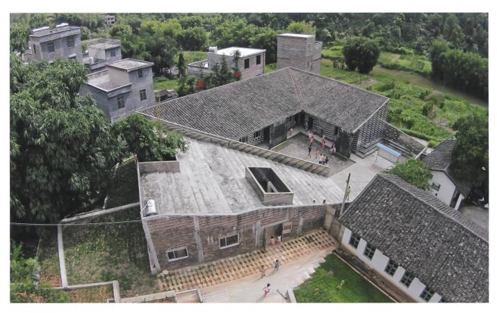
Schule Mulan: Der Neubau besteht aus Recyclingbacksteinen und -Dachziegeln. Die Anlage ist ein öffentlich zugänglicher Treffpunkt im Dorf.
