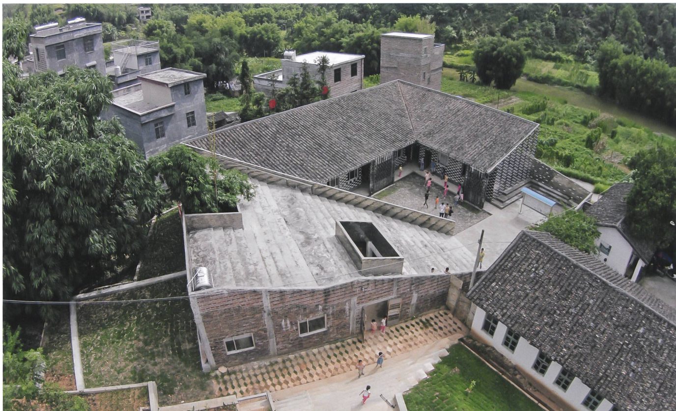
Schule Mulan: Der Neubau besteht aus Recyclingbacksteinen und -Dachziegeln. Die Anlage ist ein öffentlich zugänglicher Treffpunkt im Dorf.
