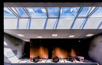
tät durch Mehrfachverglasung für maximale Dämmwerte und verbindliche Durchsturzsicherheit.
