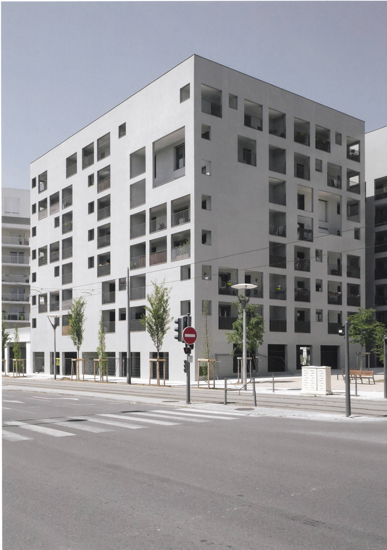
Zwei abstrakt wirkende Kuben ohne Sockel am Eingang zum neuen Stadtquartier in Lyon: Die Lochfassade verleiht den Bauten ihr Gesicht und den Loggien dahinter eine beschirmende Schale.
