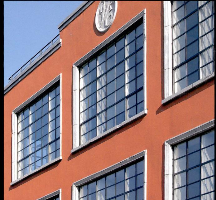
Um das Erscheinungsbild der ursprünglichen Stahlfensterrahmen originalgetreu imitieren zu können, entschied man sich für Systeme der Firma Reynaers. Das Profil ist mit einer Stärke von gerade einmal 40 Millimetern sehr schmal und wird gleichzeitig allen modernen Anforderungen wie beispielsweise einer hohen Energieeffizienz ge-
