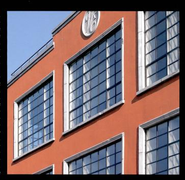
Um das Erscheinungsbild der ursprünglichen Stahlfensterrahmen originalgetreu imitieren zu können, entschied man sich für Systeme der Firma Reynaers. Das Profil ist mit einer Stärke von gerade einmal 40 Millimetern sehr schmal und wird gleichzeitig allen modernen Anforderungen wie beispielsweise einer hohen Energieeffizienz ge-
