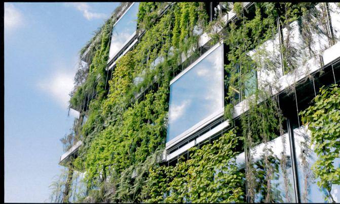
Aepli Metallbau entwickelte für den Novartis-Neubau in Basel eine Fassade, die auf einer Pfosten/Riegel-Konstruktion beruht. Damit sind Glas, Profile und Brüstungen bündig. Für die begrünte Fassade wurde
