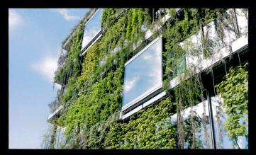
Aepli Metallbau entwickelte für den Novartis-Neubau in Basel eine Fassade, die auf einer Pfosten/Riegel-Konstruktion beruht. Damit sind Glas, Profile und Brüstungen bündig. Für die begrünte Fassade wurde eigens eine vorgehängte und begehbare Konstruktion aus Pflanzentrögen und einem Rankgerüst für die Kletterpflanzen konstruiert. Eine technisch anspruchsvolle Lösung: der Abstand der 1,7 m × 1,7 m × 0,6 m gros-
