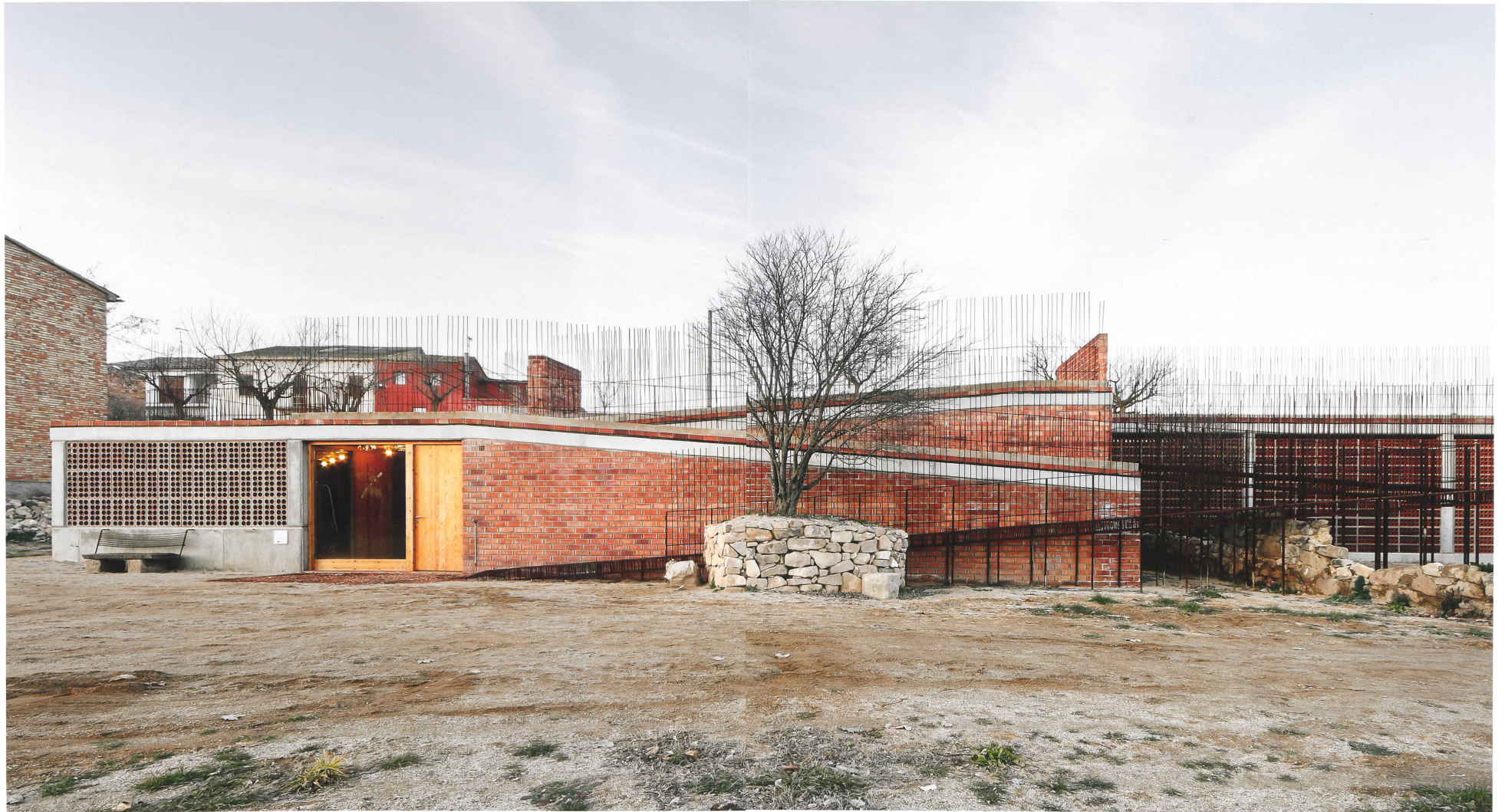
Mittel des modernen ländlichen Zweckbaus: industrieller Backstein, Betonskelett und frei herausragende Armierungsseisen fügen sich zu einem geheimnisvollen Ort am Rand des katalanischen Dorfs Seró.
