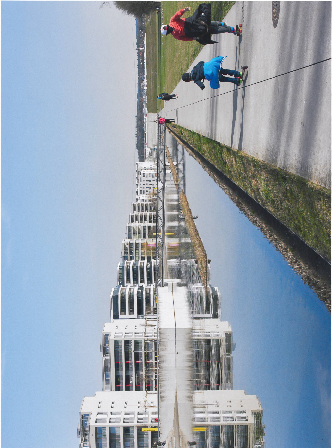
Weite der Landschaft: An den künstlichen See, der hauptsächlich von Meteorwasser gespeist wird, stossen die Zeilen der 1. (Hintergrund) und 2. Baustappe des Quartiers Glattpark. Im Hintergrund verdeckt der Lärmschutzwall der Autobahn den Kern von Opfikon.
