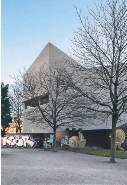
Der Erweiterungsbau des Landesmuseums in Zürich greift als abstrakte Form in den Park aus. → S. 70 Bild: Roman Keller
