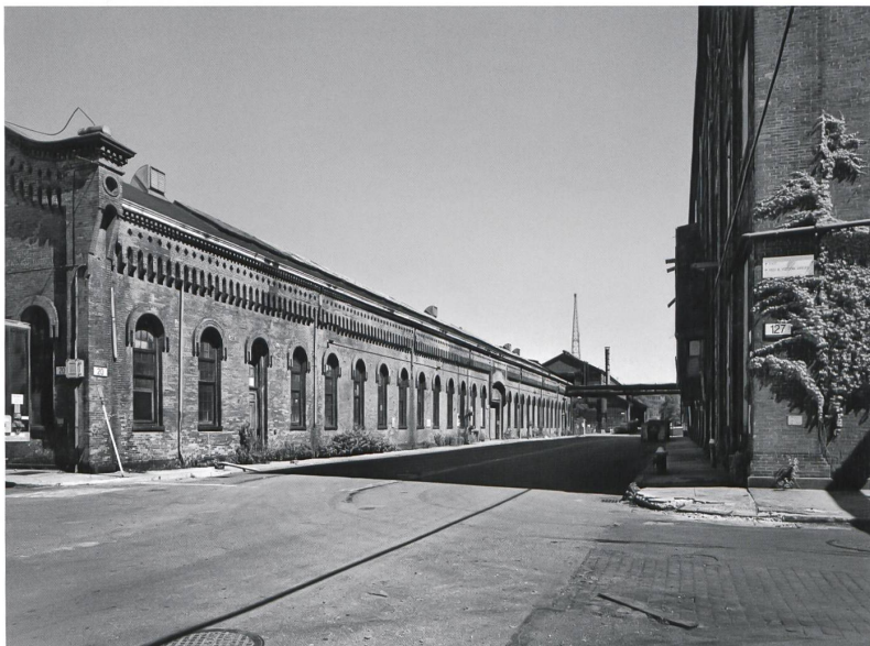
Backstein, gepflasterte Strassen und rostiges Eisen: Der Navy Yard vor seiner Wiederbelebung. In die Werkhalle 128,
