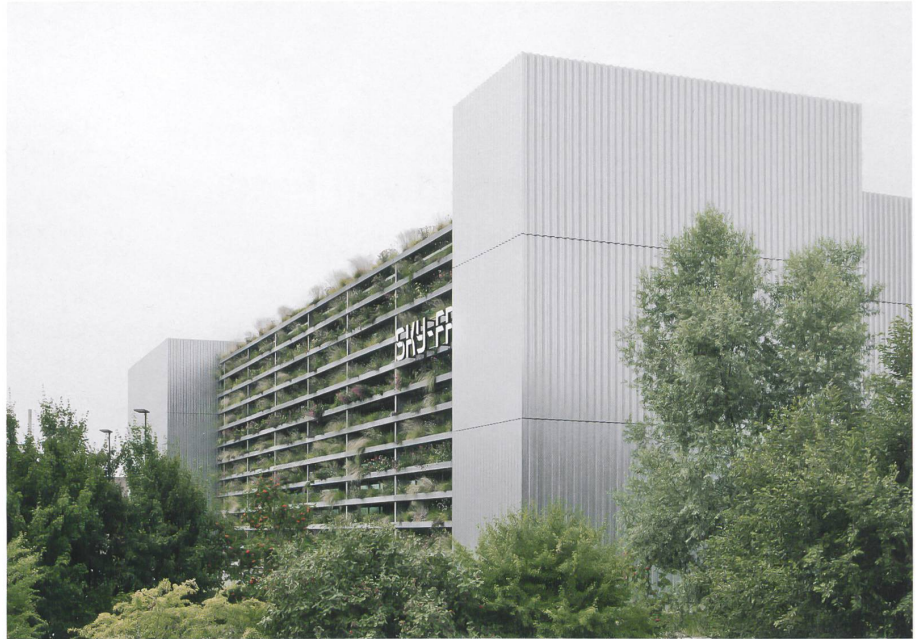
Südfassade mit dem Brise-Soleil in der Mitte, eingespannt zwischen dem Haupttreppenhaus (vorne) und dem Hochregallager
