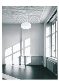
In den Schulzimmern wurde die neue Innenisolation mit einer hinterlüfte-ten Täferung abgedeckt. Bild: Hannes Henz
