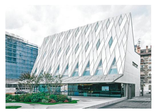
Die Struktur der Dachverkleidung erinnert an das Flechtwerk tropischer Hütten. Sie bildet die innere Tragstruktur ab, die die Kräfte des Dachs ableitet und die grosse Auskragung über dem Eingang ermöglicht. Bild unten: Blaise Glauser/MEG
