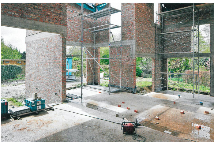
Alle konstruktiven Erfordernisse, wie beispielsweise die Ringanker aus Beton, treten aussen nach statischer Notwendigkeit in Erscheinung. Bilder: Stijn Bollaert
