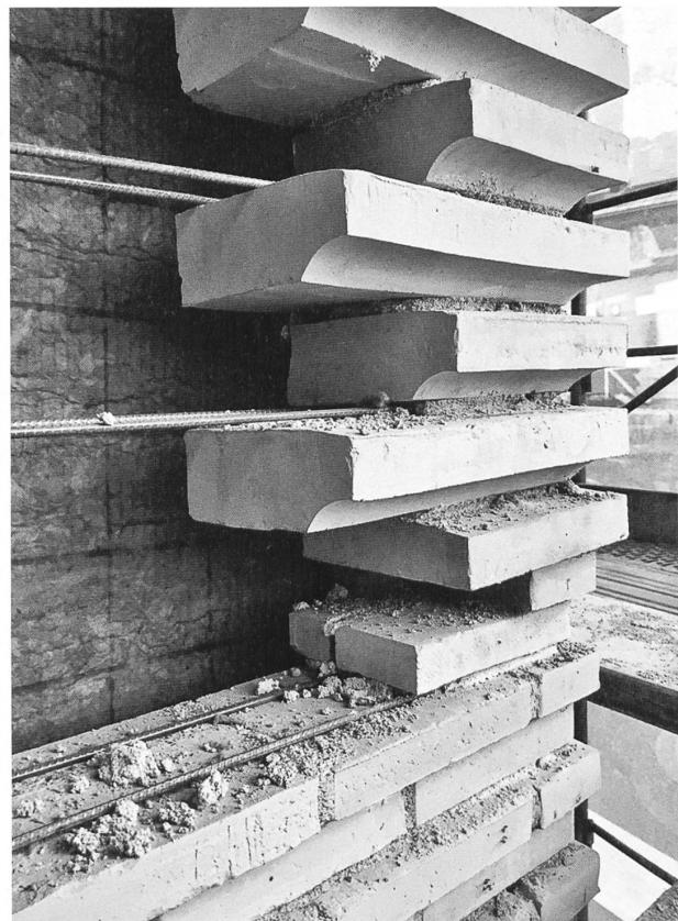
5 Formsteine I: Sie machen ein Versetzen ohne Mörtel möglich. Das Beispiel zeigt einen Trockenmauerstein aus rezykliertem Porenbeton.
