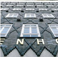
Im Mehrfamilienhaus von Paillard Jaray Leemann (Zürich, 1959) sind sämtliche Wände, äussere wie innere, aus Sichtbackstein gemauert, wobei Fusssortierung und Sichtseite in kunstvoller Absichtslosigkeit abwechseln. Bündig abgezogene Mörtelfugen betonen noch den muralen Charakter und tragen
