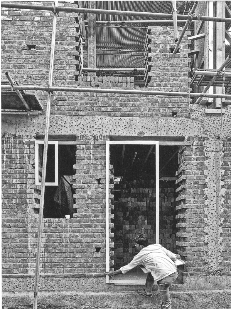
In den Mauern einer alten Textilfabrik in Mumbai entstehen sieben Hofhäuser. Die gebaute Struktur wird von Studio Mumbai als Skizze im Massstab 1:1 verstanden: Provisorische Holzrahmen stellen die Lage der gemauerten Öffnungen in Frage. Bild: Ariel Huber
