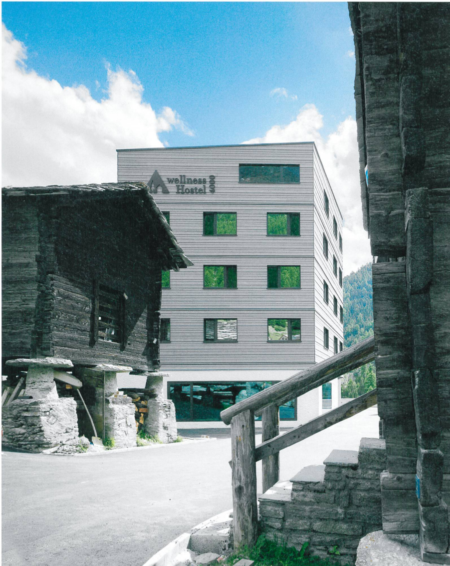
Analog zu den alten Stadeln im Dorf Saas-Fee steht der moderne Holzrahmenbau der Jugendherberge auf massivem betonierte Sockel. Fest montierte Fensterflügel spiegeln die Bergwelt. Bild: Ruedi Walti
