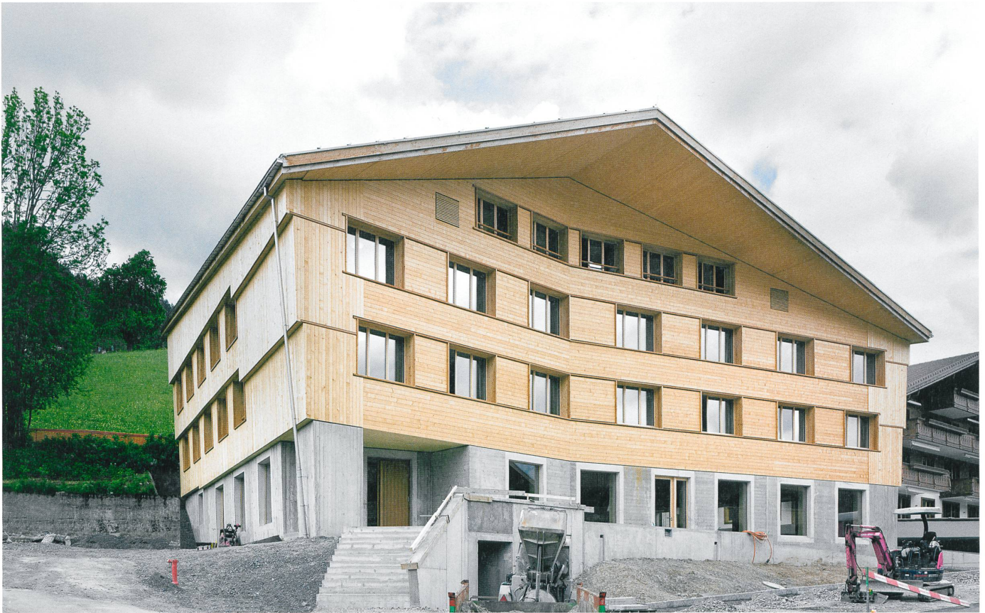
Der wuchtige Baukörper der Jugendherberge in Saanen ist dem Saanenländer Bauernhaus verpflichtet. Die Unterscheidung von Seiten- und Hauptfassade entspricht diesem auch konzeptionell. Bild: Alexander Gempeler
