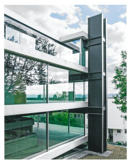
gesagt: Die Zugbänder haben vor dem Betonieren der Decken die stark nach oben vorgekrümmten Träger der zuerst errichteten Stahlstruktur in eine horizontale Lage gebracht, indem sie die Eigenlast des Betons kompensierten. Wozu dieser Aufwand?
