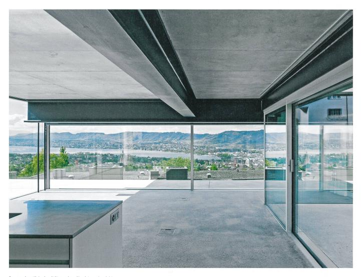
Da, wo eigentlich eine Stütze sein sollte, ist nur Aussicht. Zwei Zugbänder (links im Bild) hielten vor dem Betonieren die stark nach oben vorgekrümmten Stahlträger in der Horizontalen.
