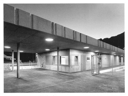
Sitzstufen dienen als gedeckte Tribüne (oben). Den Beton der Aussenflächen strukturieren die Abdrücke von in die Schalung eingelegtem Schwartholz. Bilder: Alexander Gempeler
