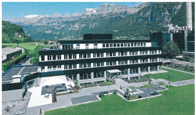
Schon die Planungswerte liessen ein Plus in der EnergierECHnung vermuten, jetzt sind Fakten verfügbar: Das Bürohaus der Flumroc AG mit 40 Arbeitsplätzen erzeugt mehr Energie als es verbraucht – ein Überschuss von 12,5 Prozent. Möglich macht dies eine energiesparende Bauweise mit sehr guter Wärmedämmung, effizienten Anlagen und Einrichtungen wie Beleuchtung,
