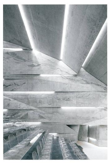
Zum Abguss der schalltechnisch optimalen Falten in den Wänden waren über 3000 Schalelemente vonnöten. Aus den Klüften blitzt das Licht und setzt Darbietung und Saal in Szene.
