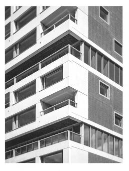
Die Fassaden sind elementar gegliedert und repräsentieren die verborgene Platten-Scheiben-Tragstruktur, aus der auch die Taillierung des Körpers hervorgeht.
