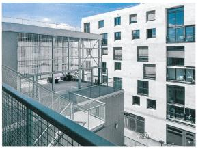
Oben: Blick aus dem verglasten, kollektiven Wintergarten, der in dem aus Massivholz erbauten Haus J private Balkone ersetzt. Im Hintergrund das zentral gelegene Haus G mit seiner Monocoque-Fassade aus bis 80 cm starkem Dämmbeton
