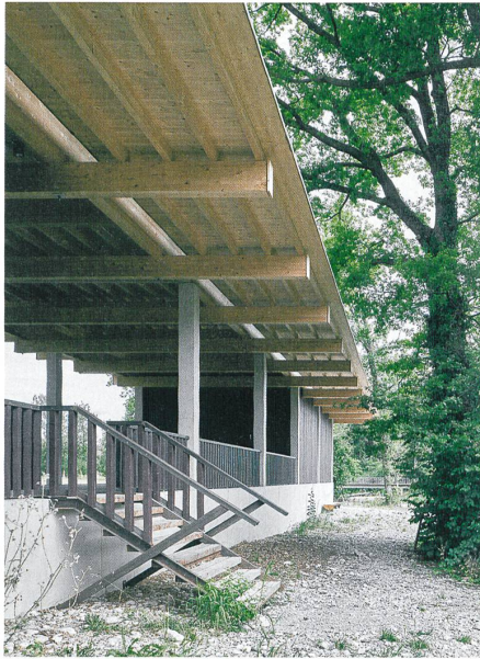
Murg-Auen-Park Frauenfeld: Die hängende Auskrugung des Vordachs und eine kleine Treppe verbinden den Pavillon mit dem Raum der Auenlandschaft, → S. 66. Bild: Roland Bernath
