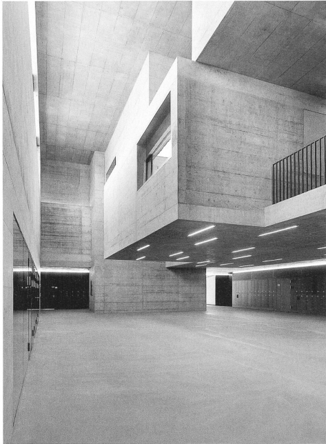
Das dramatisch inszenierte Foyer schiebt sich zwischen Altbau und Erweiterung.
