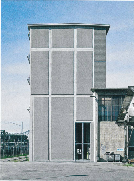
Die kassettierte Betonelement-Fassade prägt das Gesicht zum Arealplatz hin. Dahinter liegt die imposante Eingangshalle.
