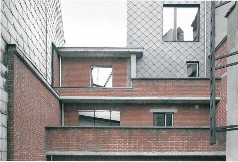
Huis Huik: Ein irgendwie seltsamer Backsteinbau in der Innenstadt wurde durch Entkernung und Aufstockung neu an seinem Ort verankert.
