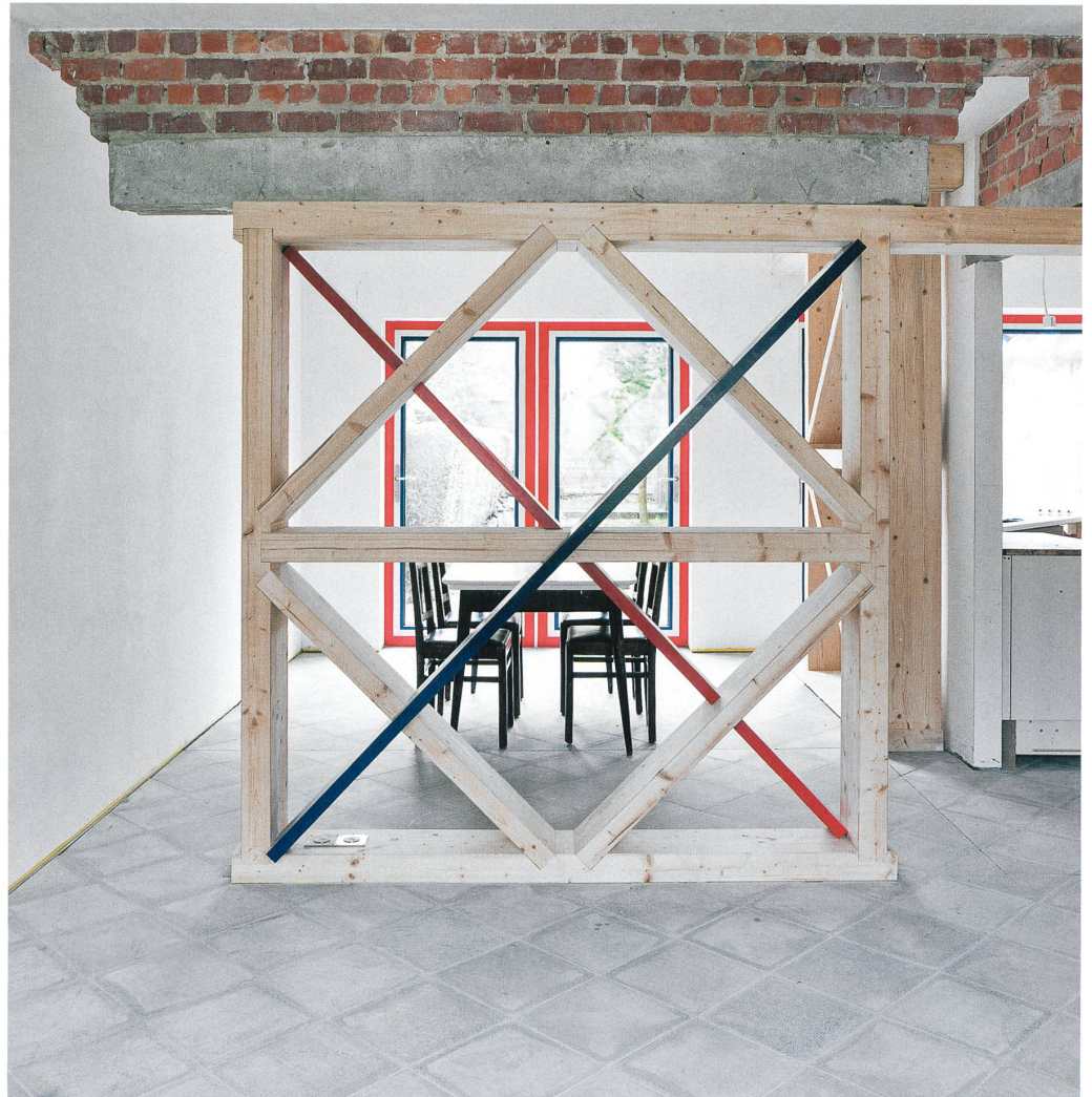
Huis Ganzendries: Da wo Türen waren, sind jetzt Gestelle aus Holz und Stahl – da, wo Wände waren, ist nun offener Raum. Bild: Tom Lagast
