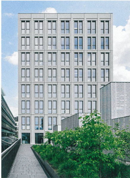
Städtische Grossform: Das Institutgebäude LEE der ETH Zürich von Fawad Kazi. → S. 66 Bild: Georg Aerni
