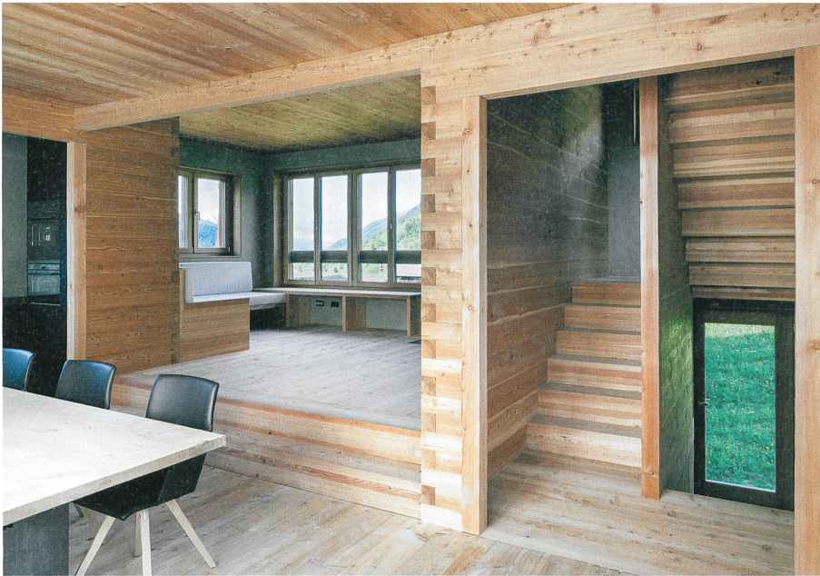
Innen und aussen bleiben das Holzmaterial Lärche und das Prinzip des Stricks nachvollziehbar. Einzig die Dämmung der Aussenwand ist innen verputzt.
