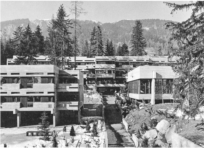
Zweimal Walliser Beton: Die 1950–61 erbaute Staumauer Grande Dixence (Bild: Heinz Preisig) und das Feriendorf in Fiesch, 1967 von den Architekten Paul Morisod, Jean Kyburz und Edouard Furrer gebaut (Bild: Fonds Paul Morisod)
