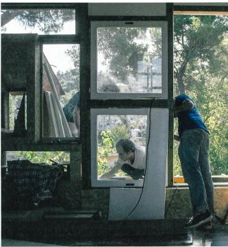
Die Waldorf-Schule *Tretzevents* von 2013 in Sant Cugat del Vallés, Barcelona, entstand im Selbstbau: Systemprofile für Spriessungen und Schwerlastgerüste (RH Estructuras) bilden dabei die Struktur des neuen Klassenraums; Schaltafeln sowie wiederverwendete Baumaterialien und Bauteile finden Verwendung für die Raumabschlüsse.
