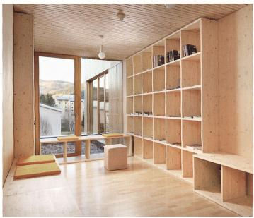
Das Tragwerk aus kreuzverleimten Fichtenholzlagen stammt aus slowenischen Beständen und wurde in Österreich gefertigt; Wandhohe Öffnungen erfüllen die ganz mit Holz ausgekleideten Räume im Obergeschoss mit Licht.
