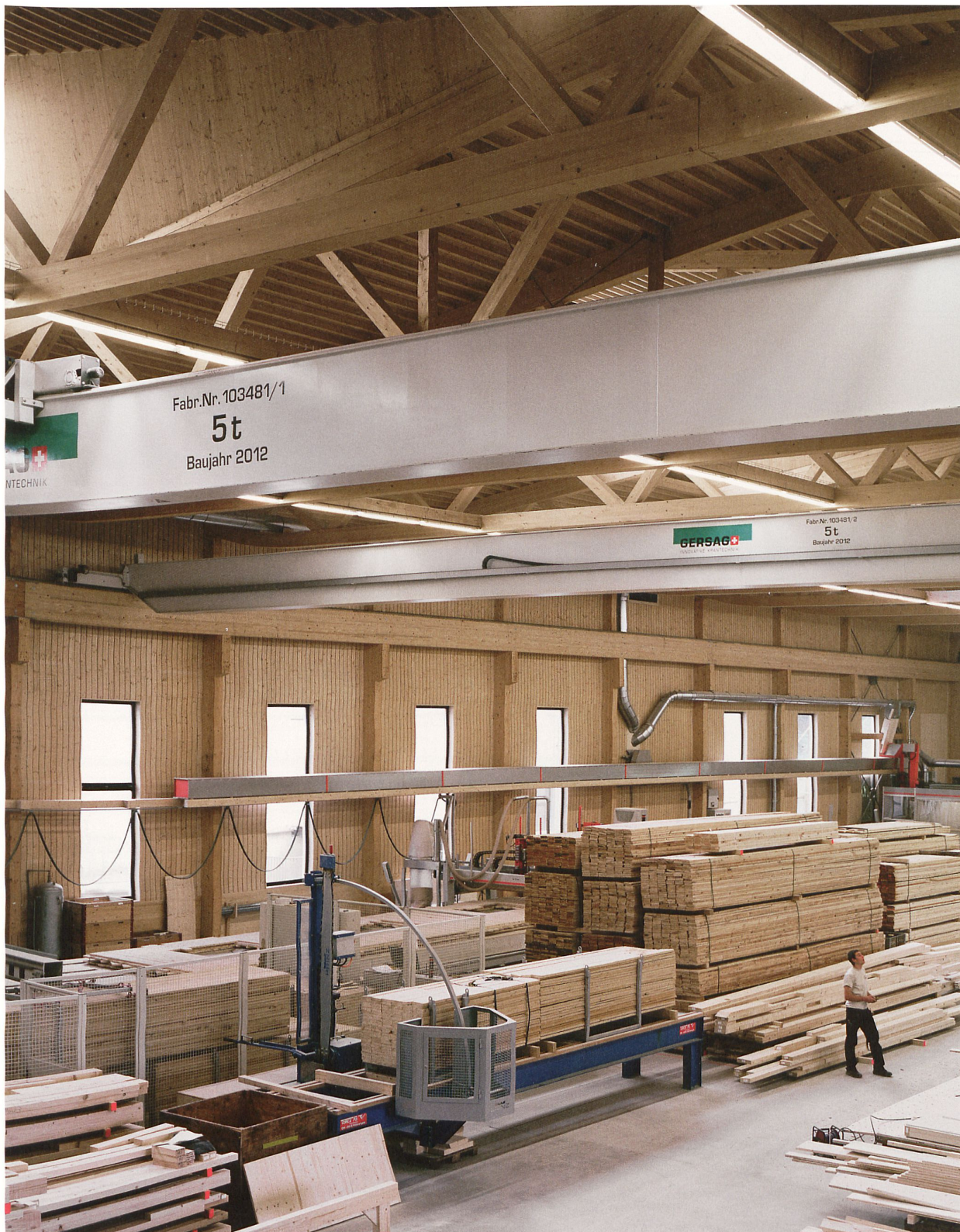
Erstaunlich schlanke Stützen tragen mächtige Brettschichtholz-Fachwerkträger; aus Holz ist sogar der horizontale Träger der Kranbahn.
