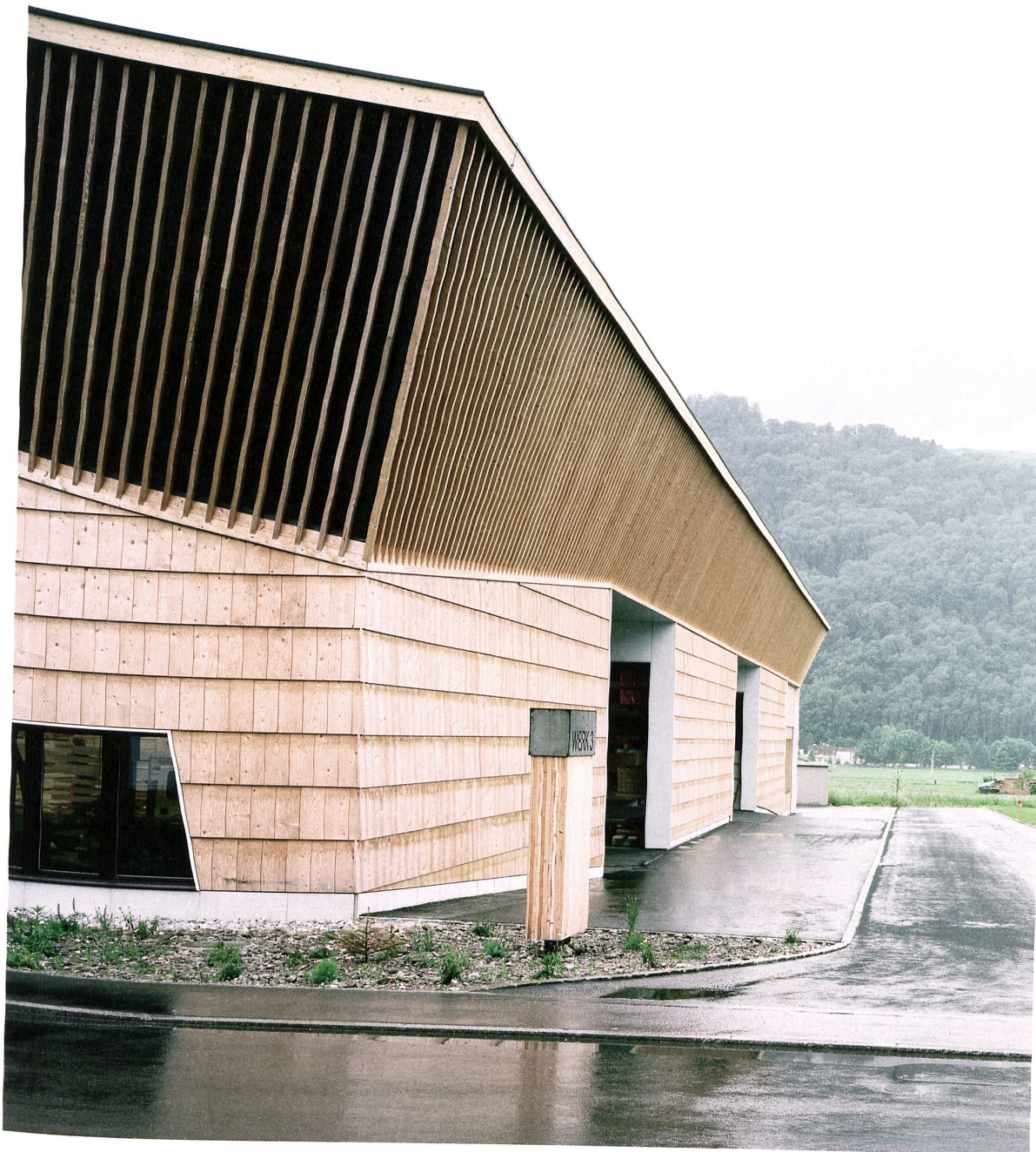
Grosse Schindeln und schräge Latten an der Dachuntersicht prägen den Ausdruck und bilden eine geschlossene, durchgehende Haut.
