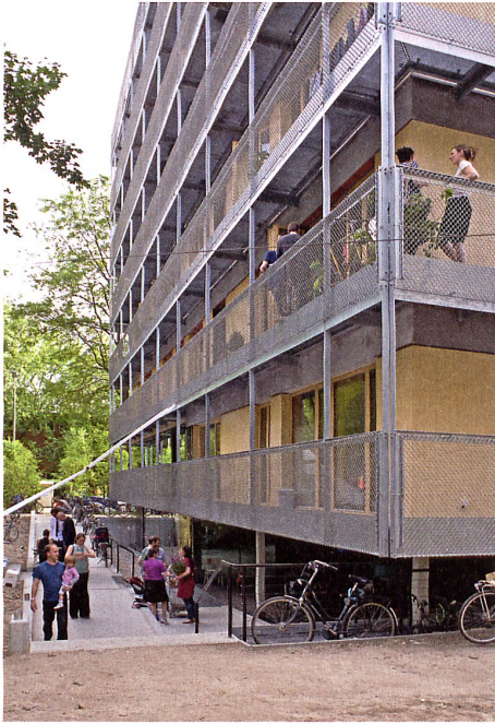
Halböffentlicher Raum zwischen Haus und Strasse: Am tief liegenden Eingang des Hauses «R 50» in Berlin-Kreuzberg liegt der Gemeinschaftsraum. Bild: Andrew Alberts
