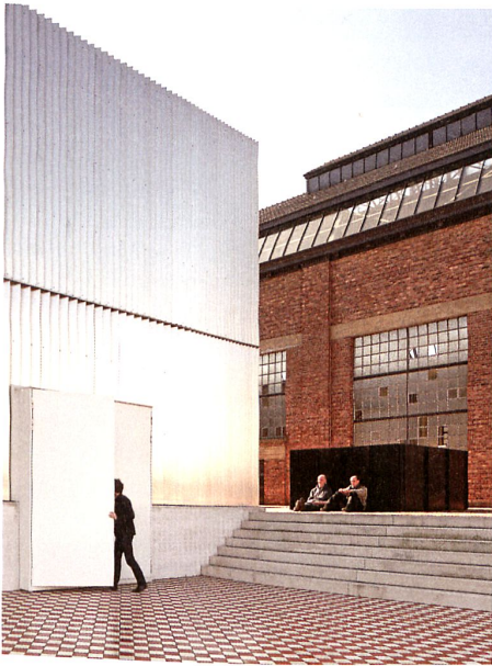
Industrie raus – Kreative rein. Der Umbau der Energiezentrale der C-Mine in Genk durch das Brüsseler Büro 51N4E zeigt die Chancen des Strukturwandels. → S. 27 Bild: Stijn Bollaert
