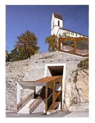
einzelne Elemente wurden auf dem unwegsamen Gelände mit ausgeklügelten Arbeitsvorgängen bergwärts montiert. Das Zusammenschweissen der einzelnen Elemente erfolgte vor Ort durch den Stahlbauunternehmer. Zum Auftrag von Tuchschmid gehörte auch die Herstellung, Lieferung und Montage des gewellten, rostfarbenen Treppengeländers aus Lochblechen.
