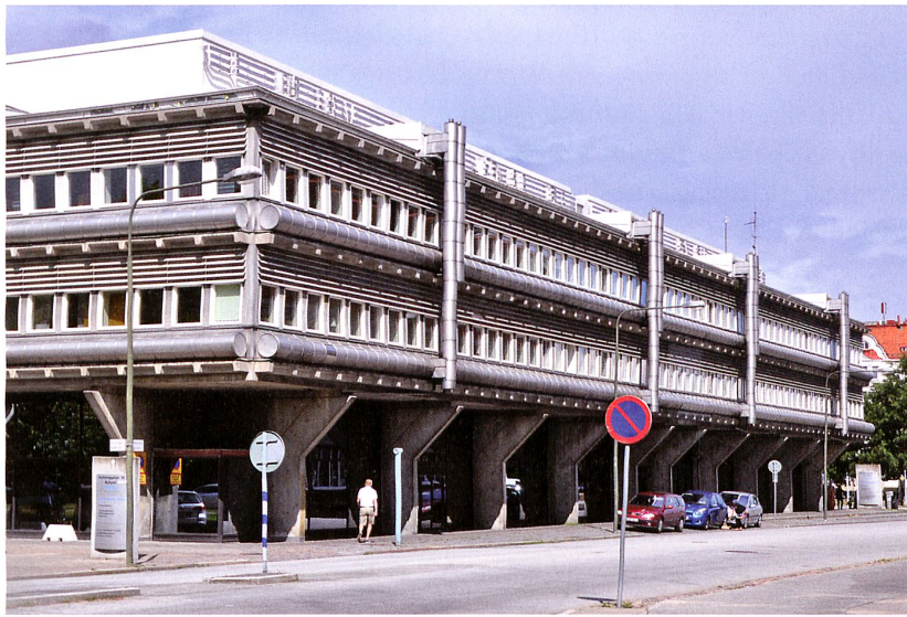
Die innere Flexibilität des Verwaltungsgebäudes Landstatshuset in Malmö (1974) mit seinen Grossraumbüros wird durch die nach aussen gelegten Lüftungskanäle sichtbar gemacht, die das Relief der Fassade prägen. Bilder: Christoph Wieser, Plan: Archiv Vanja Knocke
