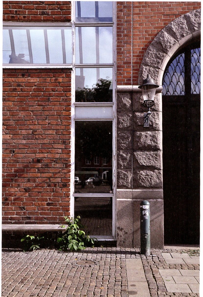
Städtebauliche Kontinuität im Detail: Beim Anschluss an das Nachbargebäude übernimmt Anshelm auf einer kurzen Strecke die Sprache des Altbaus, um erst dann mit einem Fensterschlitz die Zäsur deutlich zu machen.
