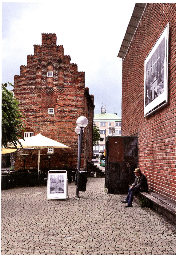
Für die Kunsthalle in Lund (1957) wurde ein mittelalterliches Backsteinformat verwendet, um so das freigestellte Krognoshus mit dem Treppengiebel mit einzubeziehen. Bilder: Christoph Wieser, Plan aus: 9H No.9
