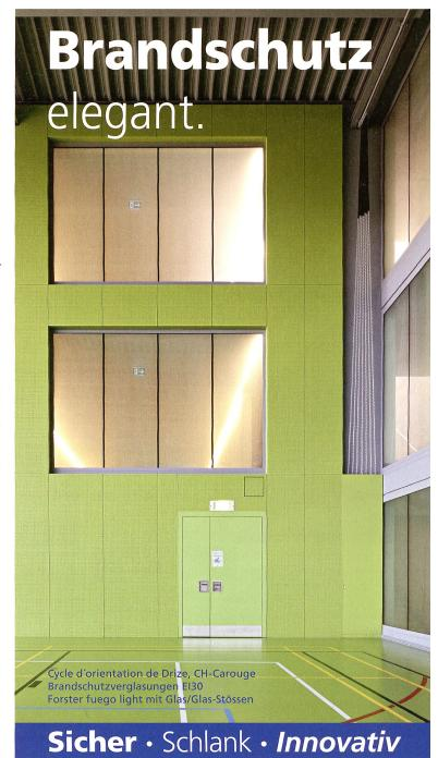
Stossfugen-Verglasungen **E130** & **E160** mit dem System Forster fuego light sind geprüft und zugelassen mit VKF Brandschutzanwendung, inkl. Eckverglasungen und Einbau von Brandschutztüren. Minimale Fugen zwischen den bis zu 1800 × 3500 mm grossen Gläsern sorgen
