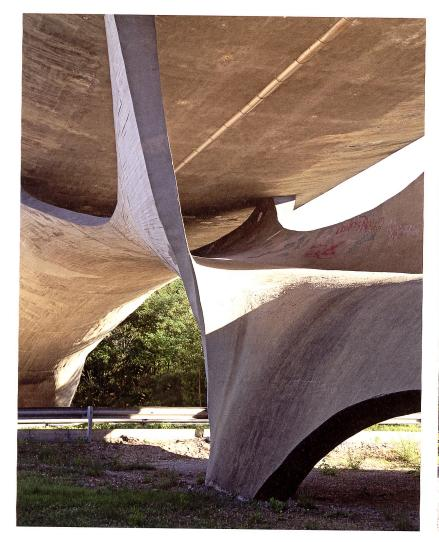
Das Tragwerk aus mehrfach gekrümmten Flä-chen spannt als kontinuierliche Betonkon-struktion von wenigen Zentimetern Stärke über vier Felder und bildet zugleich einen für Fussgänger begehbaren Raum.
