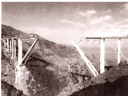
Ausgehend von der Mechanisierung des Bauprozesses wird das Sprengwerk in Stahl zur mechanischen Komponente erhoben. Bild aus: Angelo Villa, Silvano Zorzi, Milano 1995
