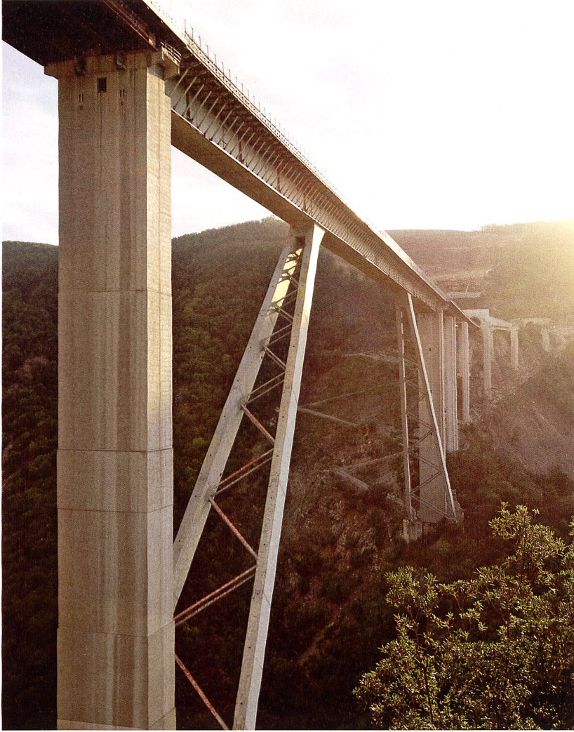
Ausgehend von der Mechanisierung des Bauprozesses wird das Sprengwerk in Stahl zur mechanischen Komponente erhoben. Bild aus: Angelo Villa, Silvano Zorzi, Milano 1995
