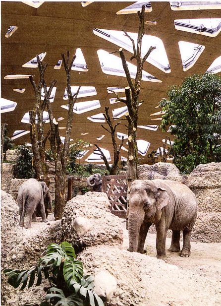
Eine flachgedrückte Schale aus Holz überspannt den neuen Lebensraum der Elefanten im Zürcher Zoo. Das in mehreren Holzlagen aufgebaute netzartige Tragwerk überspannt 85 Meter. → S. 28 Bild: Dominique Marc Wehrli
