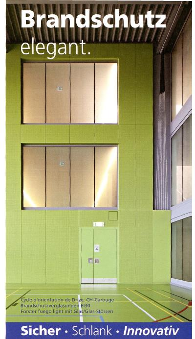
Stossfugen-Verglasungen **E130** & **E160** mit dem System Forster fuego light sind geprüft und zugelassen mit VKF Brandschutzanwendung, inkl. Eckverglasungen und Einbau von Brandschutztüren. Minimale Fugen zwischen den bis zu 1800 × 3500 mm grossen Gläsern sorgen für viel Licht.
