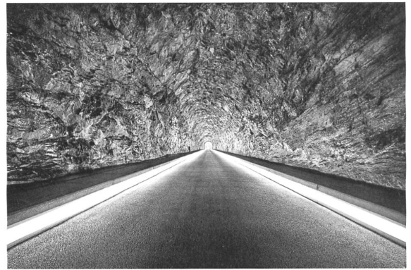
Zugangsstollen zur Kavernenzentrale Ferrera (Fertigstellung 1963), 2011. Bild: Luca Zanier Photography, Zürich
