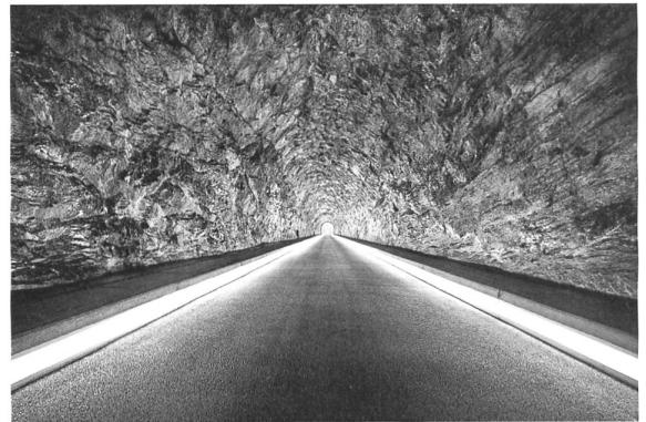
Zugangsstollen zur Kavernenzentrale Ferrera (Fertigstellung 1963), 2011. Bild: Luca Zanier Photography, Zürich
