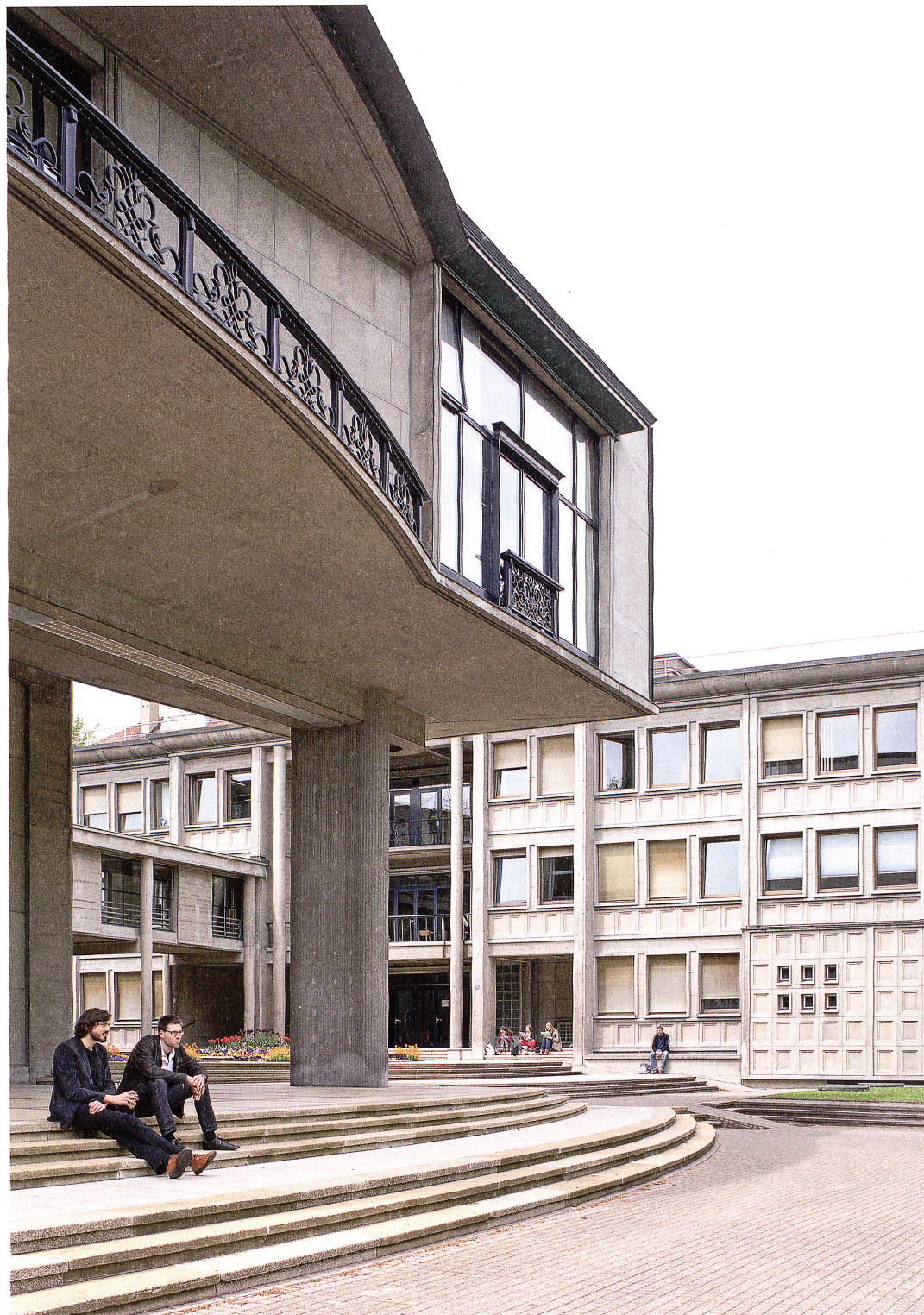
Universitätsgebäude Miséricorde der Architekten Denis Honegger und Alexandre Dumas, 1937–41. Der vornehme, grosszügige Zentralkorpus auf mächtigen Pfeilern ist in Stahlbeton ausgeführt und mit Stahlgittern des Atelier Brandt geschmückt. Er beinhaltet vornehmlich das Rektorat und, im hinteren Teil, die grosse Aula der Universität. Im Hintergrund ruht der Seminartrakt mit seinen charakteristischen Hebefenstern.
