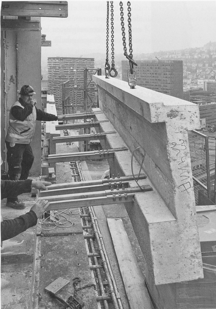
Im Bereich der Loggien Montage eines auf die reliefierte äussere Schale reduzierten Krag-elements, das als Brüstung dient. Bild: Walter Mair
