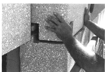
Eine der Schalungsmatrizen, im Bereich der Lisenen selber als glatter Zementkörper ausgeführt. Für die Stellen mit nachträglich starker Sandstrahl-Bearbeitung wurde eine herkömmliche Stahlschalung verwendet. Die komplexe Geometrie der Elemente wird deutlich in der mehrfach verschnittenen Geometrie der Schalung und entsprechend aufwändigen, hybriden Konstruktionsweise.
