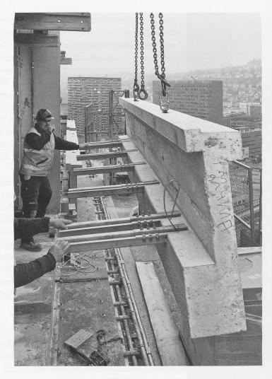
Im Bereich der Loggien Montage eines auf die reliefierte äusssere Schale reduzierten Kragelements, das als Brüstung dient. Bild: Walter Mair
