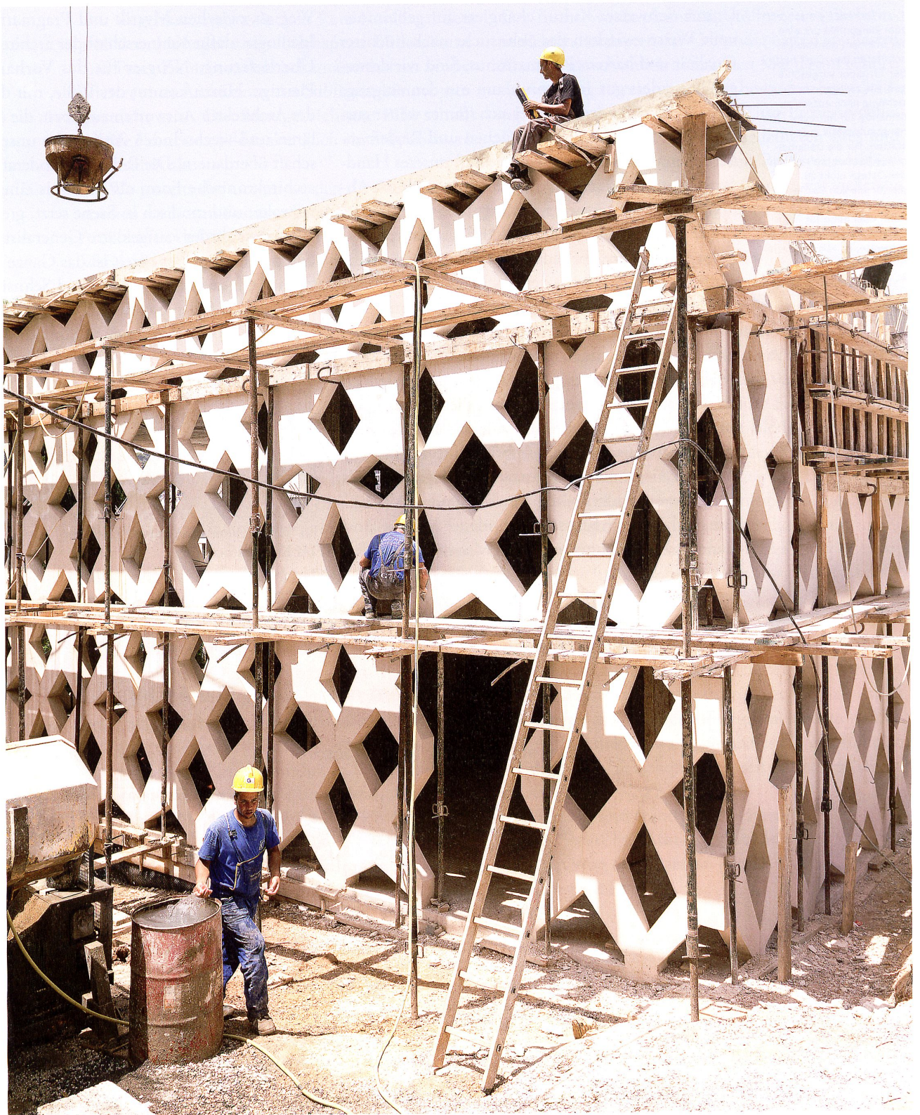
Die Fassade im Bau: algerische Handarbeit für arabisches Ornament in erdbebensicherer Schweizer Präzision.
