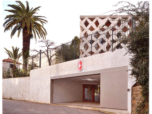
Schengen-Aussengrenze: Wehrhafter Eingang zur Visa-Abteilung im Sockelgeschoss. Bild: Marco Bakker
