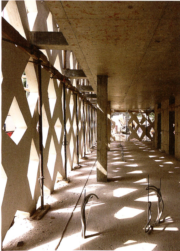
Blick in die Baustelle: Raumeinteilung, Stützenraster, Fenster und Betonelemente folgen je eigenen Rastern.
