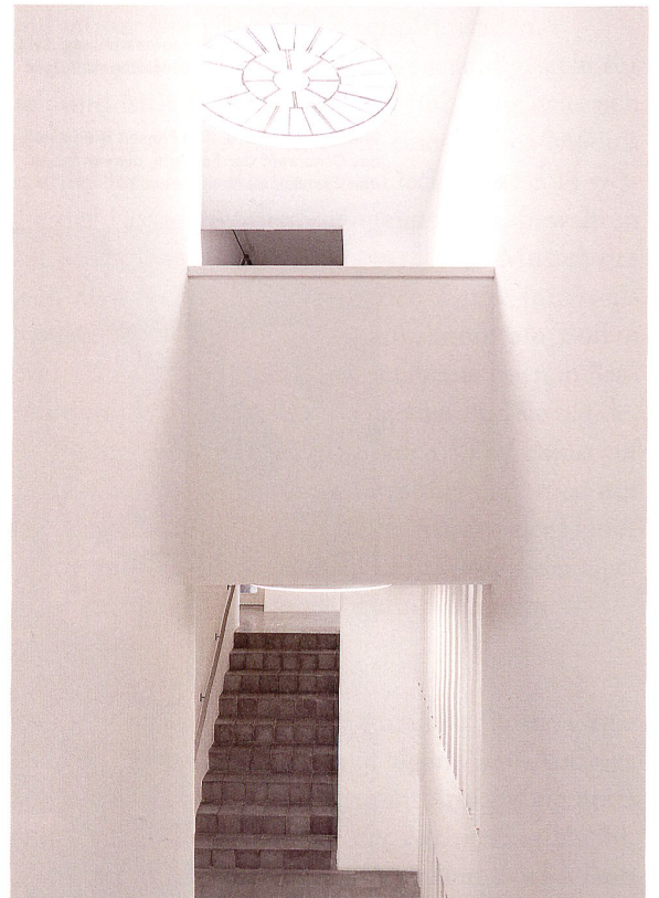
Der Erschliessungsraum mit sich kreuzenden Treppen in der Gebäudemitte ist wie in arabischen Häusern von oben belichtet.
