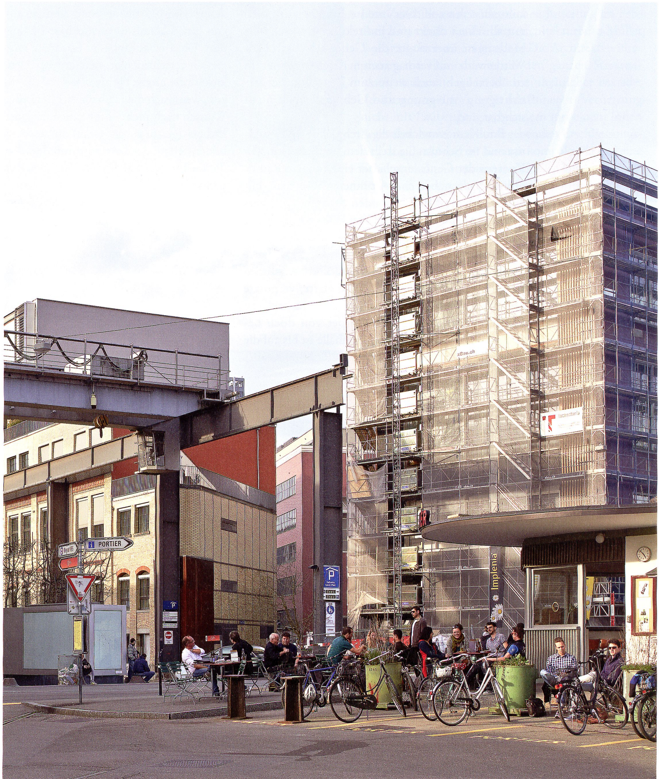
Beim Restaurant «Portier» am Eingang zum Lagerplatz kommt alles zusammen: Die Weite des Katharina-Sulzer-Platzes (links) und die engen Gassen beim neuen «Superblock», Studierende und Büroangestellte, Velos und Kinderwagen.
