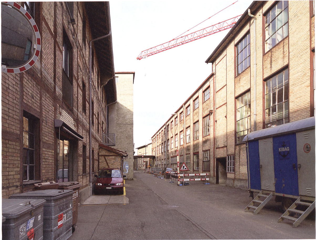
Gassenraum im Areal Lagerplatz. Hier bleiben alle bestehenden Bauten stehen und werden schrittweise instandgesetzt.
