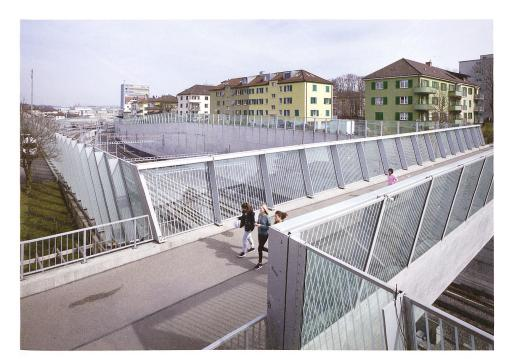
Verdichtung auf engem Raum: Der Bahneinschnitt in Oerlikon wurde von vier auf sechs Spuren ausgebaut; dabei mussten bis zu 33 Meter hohe, zum Teil überhängende Stützmauern erstellt werden (Bild unten). Lärmschutzwände aus Stahl und Glas schliessen die Mauern nach oben ab, im Bild rechts der Birchsteg.
