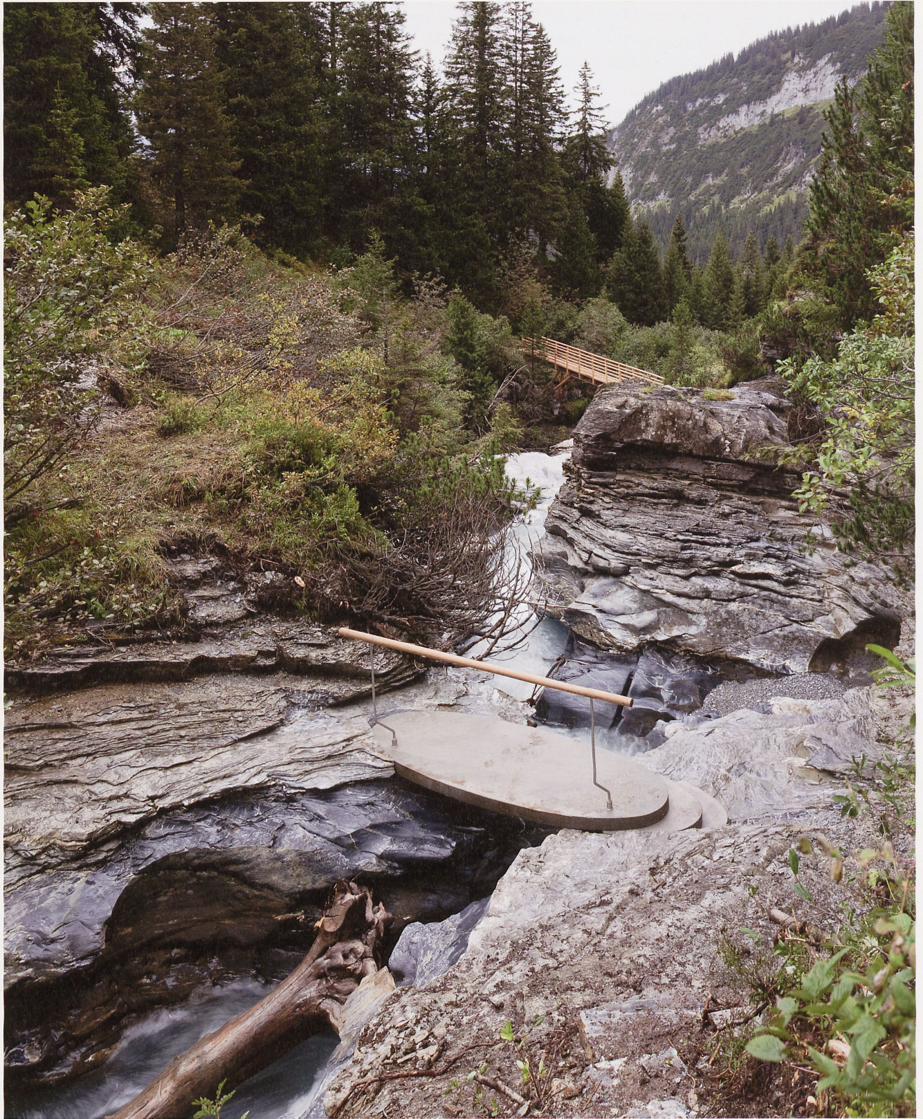
Der Wanderweg über sieben Brücken inszeniert die Berg- und Wasserlandschaft hoch über Flims.
